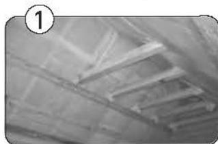
Кровельную пароизоляционную плёнку следует укладывать рефлекторным слоем внутрь здания. Плёнка монтируется параллельно карнизу.
