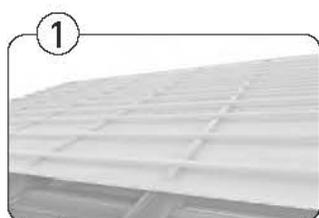
Кровельная супердиффузионная мембрана монтируется непосредственно на стропила поверх утеплителя и закрепляется контрбрусом с образованием вентиляционных каналов.
