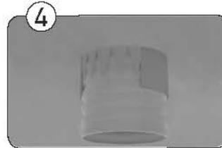
Примыкания и отверстия в плёнке заклеиваются ремонтной лентой.
