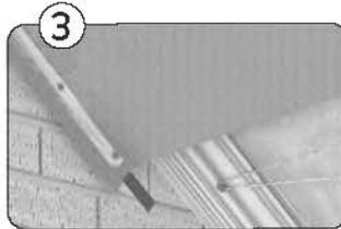
При соединении со стеной, дымоходом и т.п. Кровельная пароизоляционная плёнка должна закладываться внутрь (на 5-10 см) и плотно приклеиваться к преграде при помощи бутилового клея. Рекомендуется также прижатие плёнки и бутилового клея при помощи прижимной планки.
